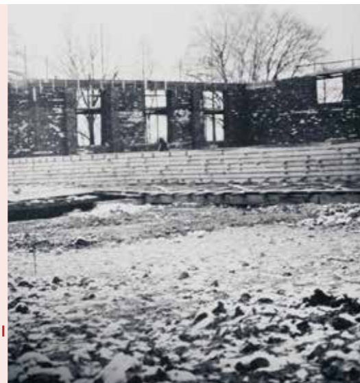
Genehmigung erteilt und schon Ende November 1925 sieht man gewachsene Mauern (links).
