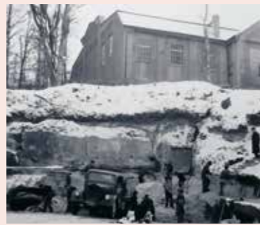
Der im Bombenangriff zerstörte Bunker wird wieder aufgebaut.
